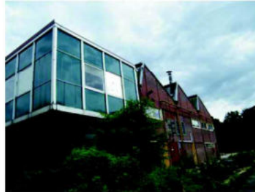
Bâtiment en attente de démolition
