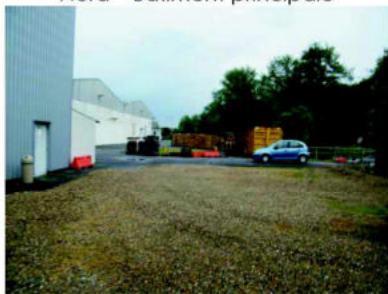
Partie bâtiments industriels – zone Nord – Zone dépôt
