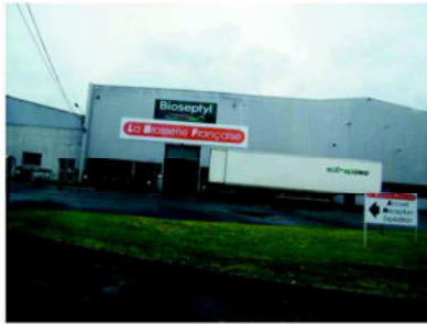
Partie bâtiments industriels – zone Nord – Bâtiment principale
