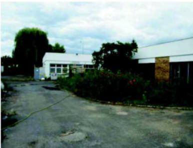
Bâtiment en attente de démolition
