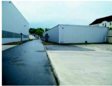
Partie bâtiments industriels – zone Nord – Bâtiment annexe
