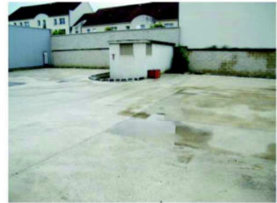
Partie bâtiments industriels – zone Nord – Transformateur Ouest
