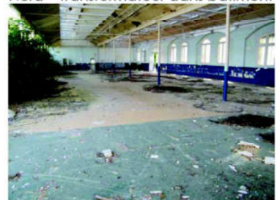
Partie bâtiments industriels – zone Sud – Intérieur ancien magasin produits finis
