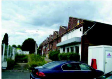
Bâtiment avec local sécurité + postes de livraison gaz et électricité (à gauche)
